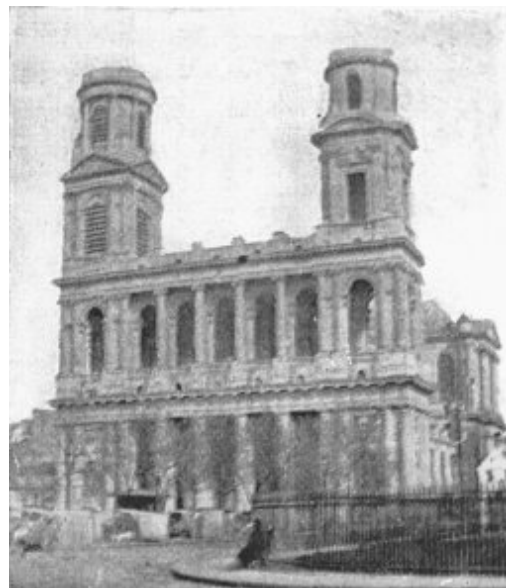
FIG. 183.—FAÇADE OF ST. SULPICE, PARIS.
